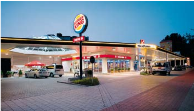
»» Mit dem Neubau einer Westfalen-Tankstelle in Münster errichtete die Westfalen AG zugleich ihr erstes Burger King®-Restaurant, das sie als Franchisenehmerin auch betreibt.
